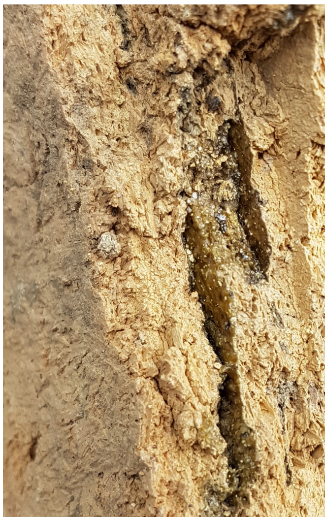
Afb. 92. Loodglazuur tussen aangesmeerde gemagerde kleilagen. Alphen, 1734-1739.
